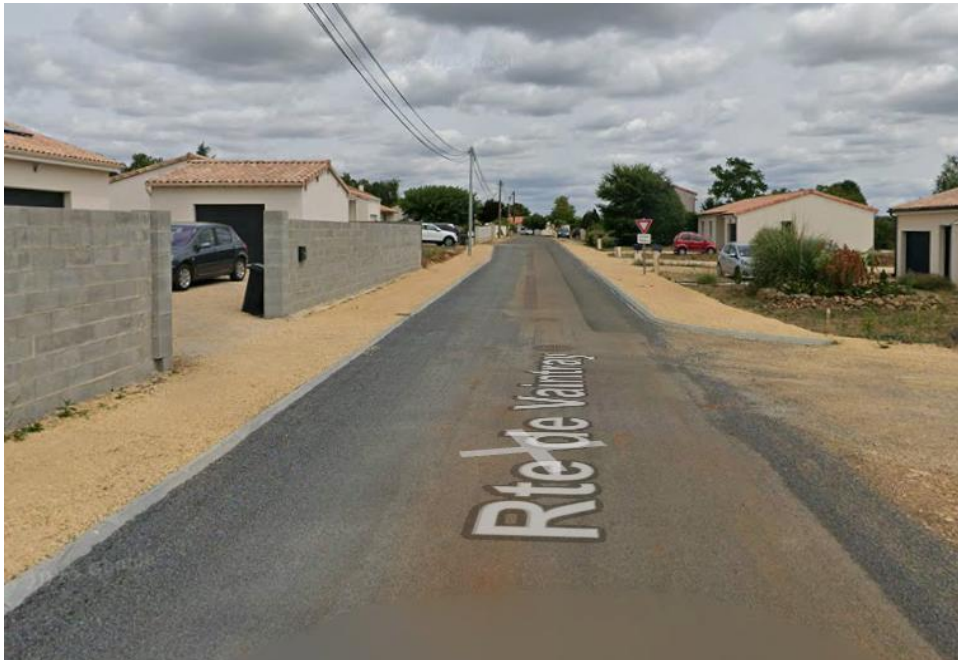
Photo des travaux de voirie réalisés, ASLONNES Source : MAPS ; 2026
