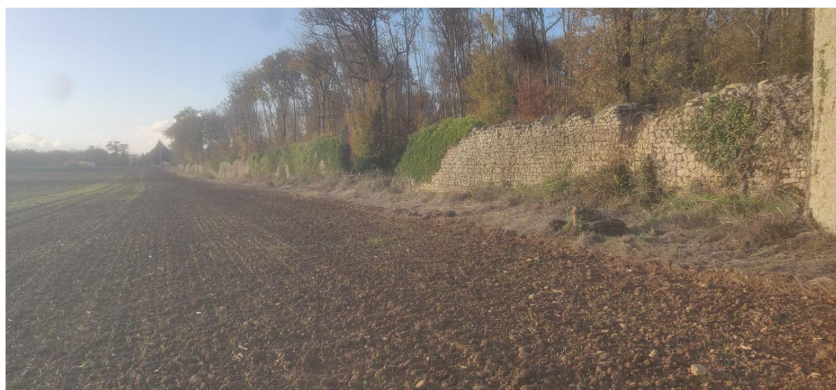
Mur entourant la propriété, Roches Prémarie Andillé Source : M. de la Martinière ; 2025
