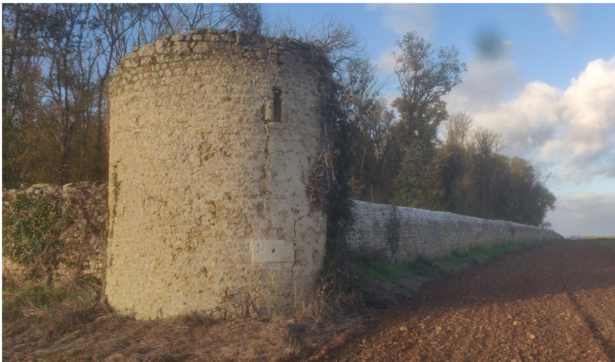
Mur entourant la propriété, Roches Prémarie Andillé Source : M. de la Martinière ; 2025
